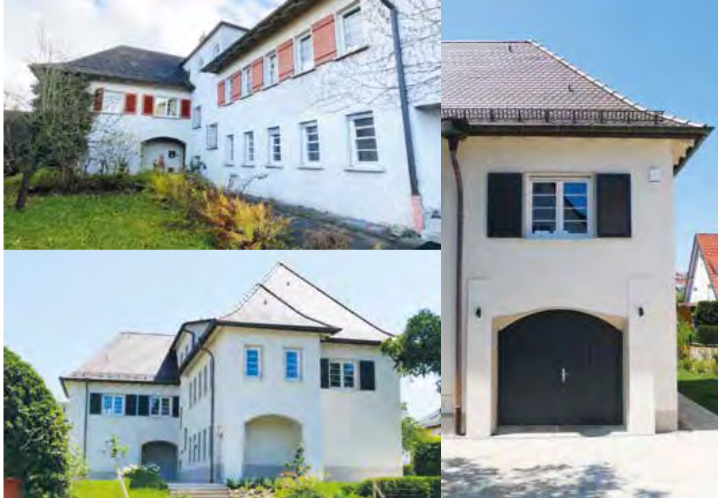
Das Gebäude vor und nach der Sanierung.
