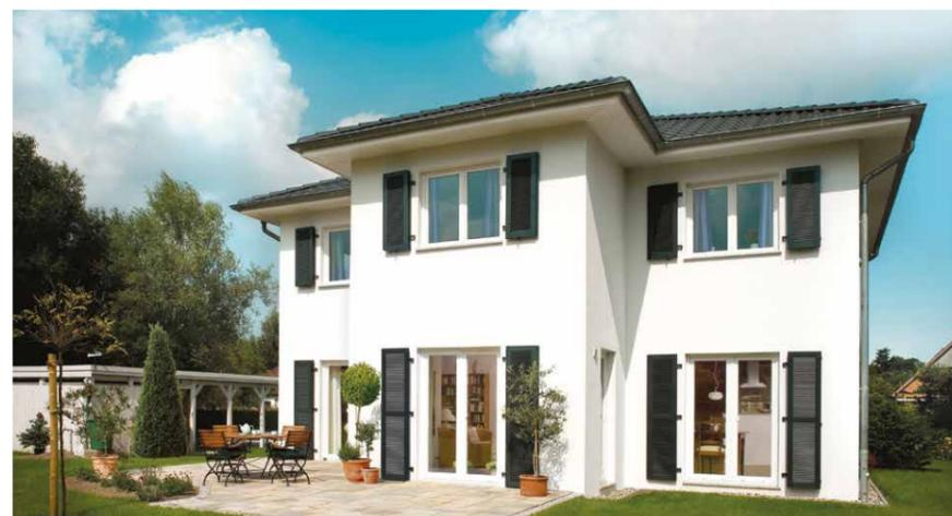
Aus dem Haus ist nahezu eine mediterrane Villa geworden. Im Erdgeschoss wurden die kleinen Fenster komplett durch bodentiefe hochwärmendämmende Fenstertüren mit einer GAYKOSafeGA® Sicherheitsausstattung ersetzt. Ein neuer Anstrich und die Ergänzung aller Fenster mit harmonischen Klappläden, verleihen dem Haus zusätzliches Flair.
