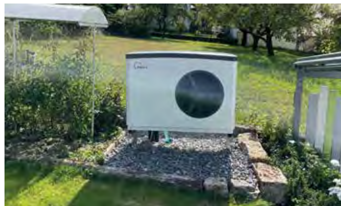
Der Aufstellort der künftigen Wärmepumpe wird vor Ort mit den Kunden besprochen. Foto: Fa. Häfele
